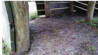
Bild 36: Fast alle Stänbalken sind im Erdboden morsch und zerfallen
