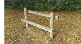
Bild 29: Stroh/Rechtbahn einseitig Pfosten und Querbalken sind erheblich gealtert und morsch Ein Wiederaufbau wird nicht empfohlen.
