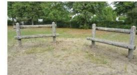
Bild 30: Stroh/Rechtbahn doppelt Pfosten und Querbalken sind erheblich gealtert und morsch Ein Wiederaufbau wird nicht empfohlen.
